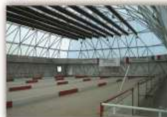
Impianto per il gioco della BOCCE
